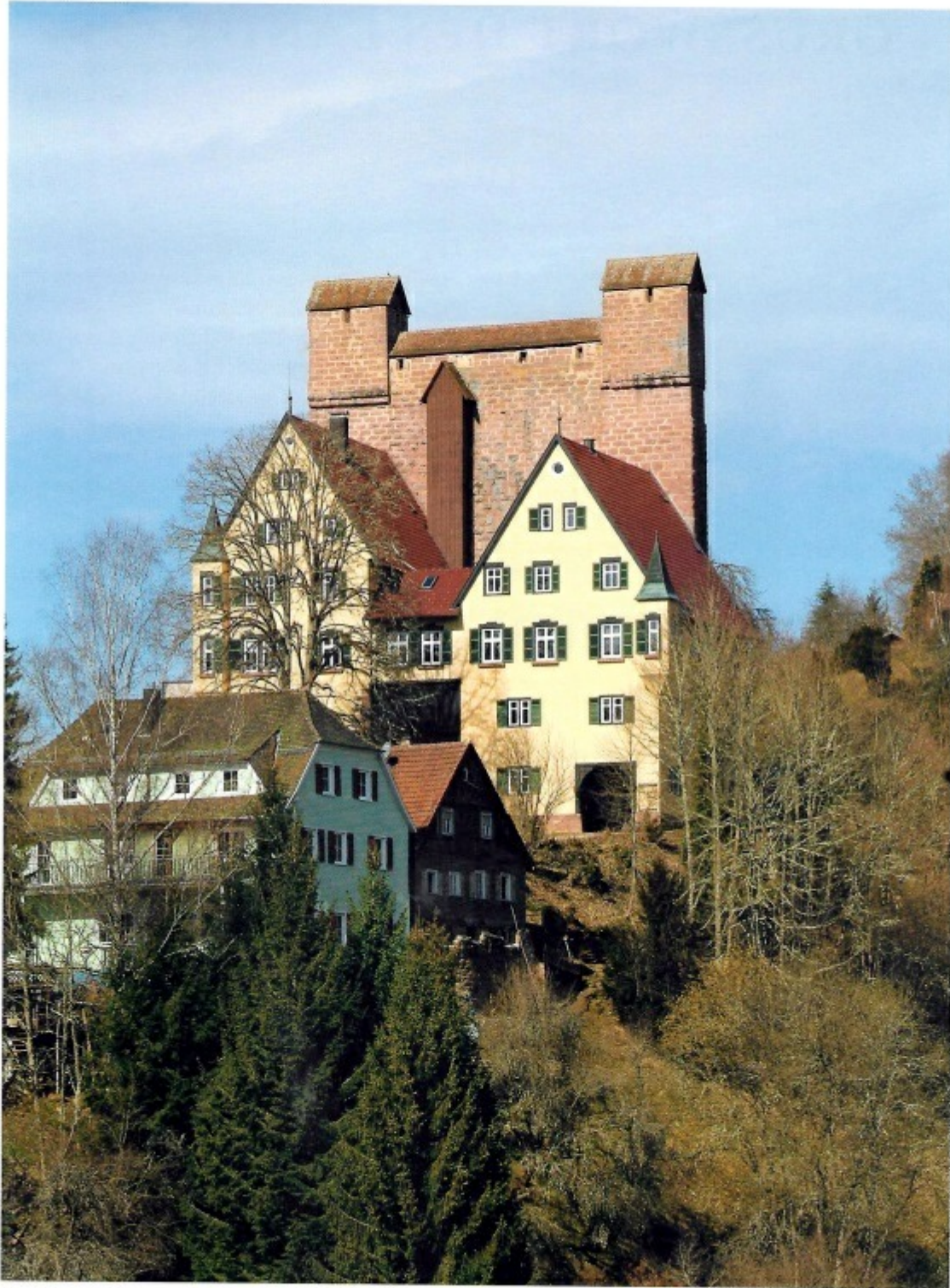
Überaus wehrhaft stellt sich Burg Berneck dar mit Schildmauer, Wehrgang und den beiden Kampfhäusern (2018).
